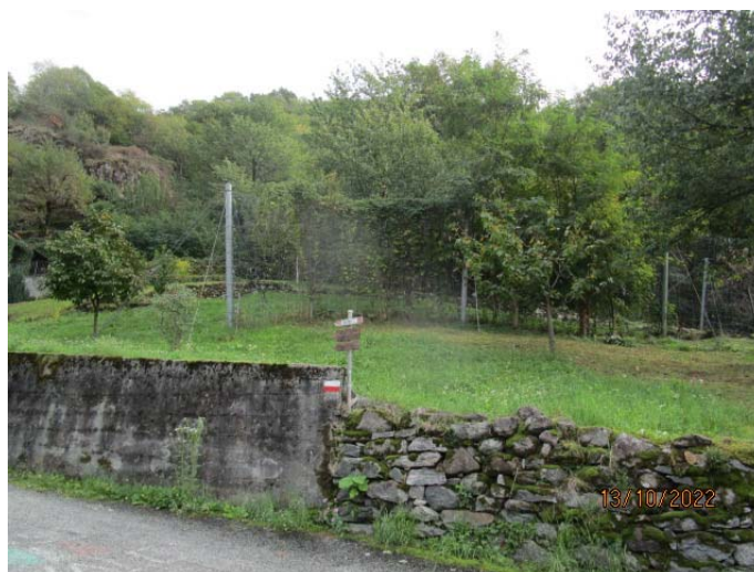
Opere di protezione del versante a monte dell'abitato di Verceia
